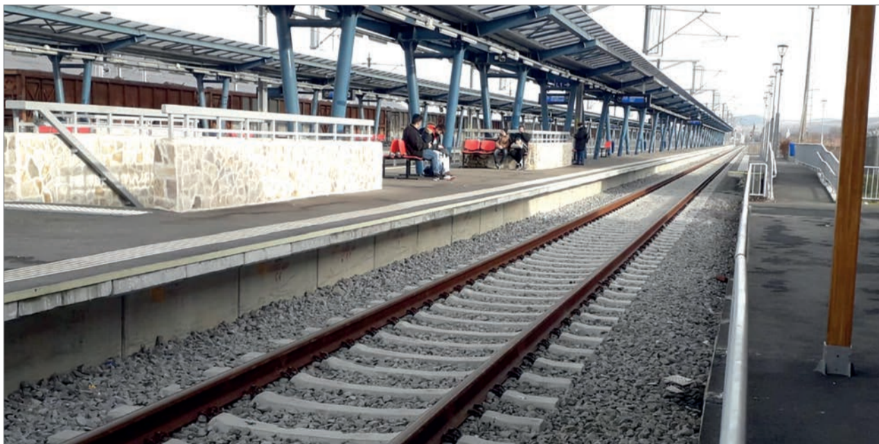
Sínen a felújítás. A Kolozsvár–Nagyvárad–Biharpüspöki-vasútvonalat villamosítják és az állomások is megújulnak
