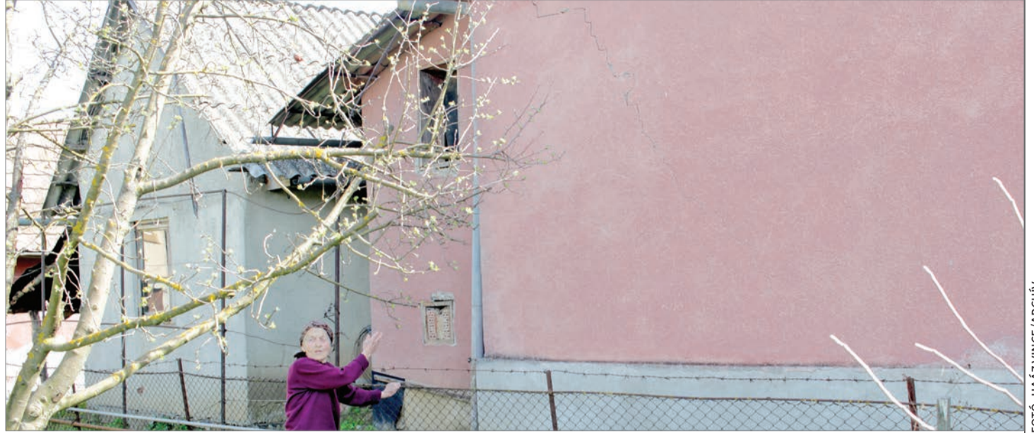
Házrepedező probléma. Hosszú évek óta panaszkodnak a lakosok a nagy károkat okozó teherforgalomra
