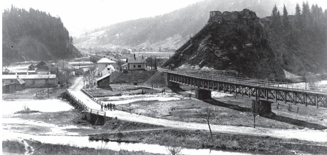
A Tatroszon átívelő vasúti híd (ma Gyimes falu, Gyimesbükk község, Bákó megye), ezt foglalták el elsőként a románok Erdélyben
