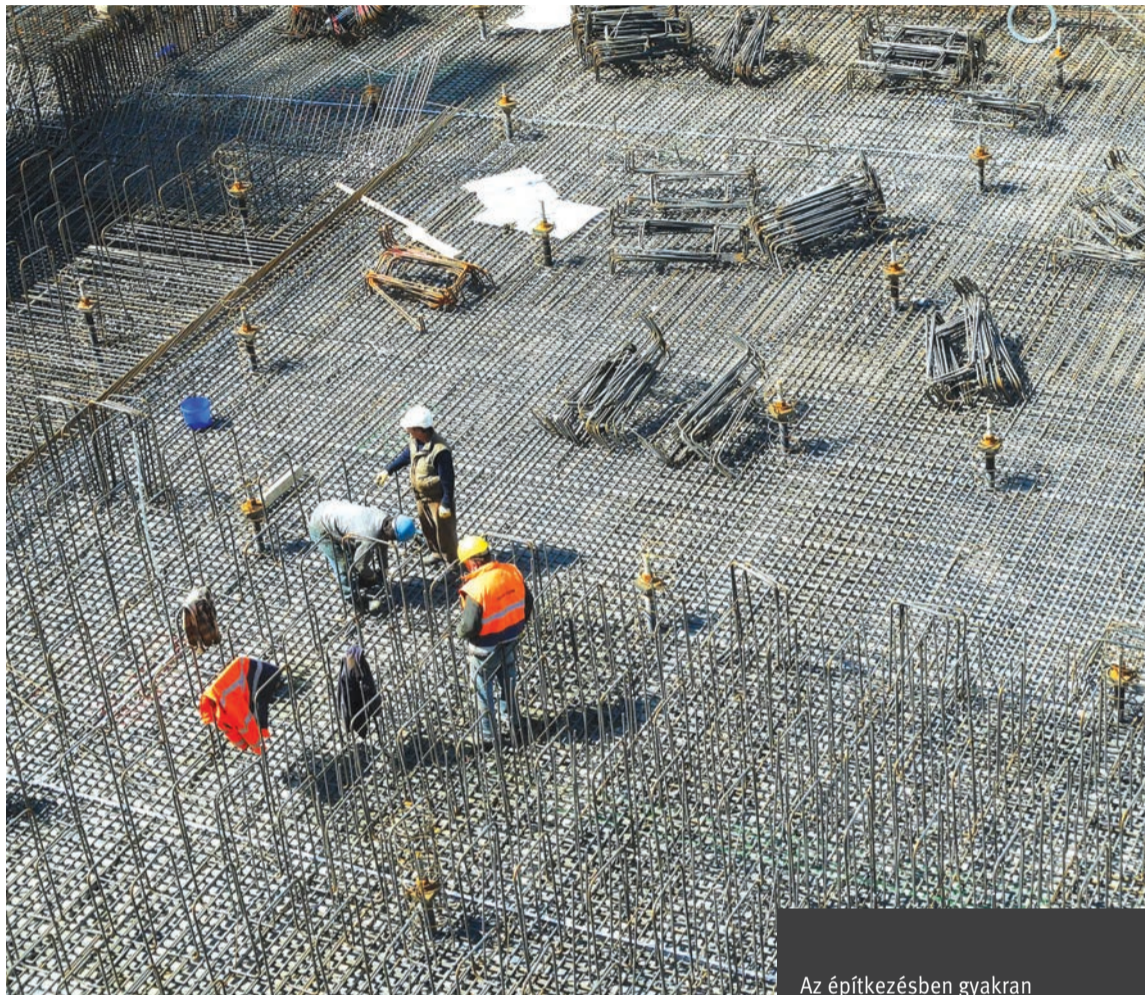
Az építkezésben gyakran „feketén” dolgoznak a szakképzetlen munkások
