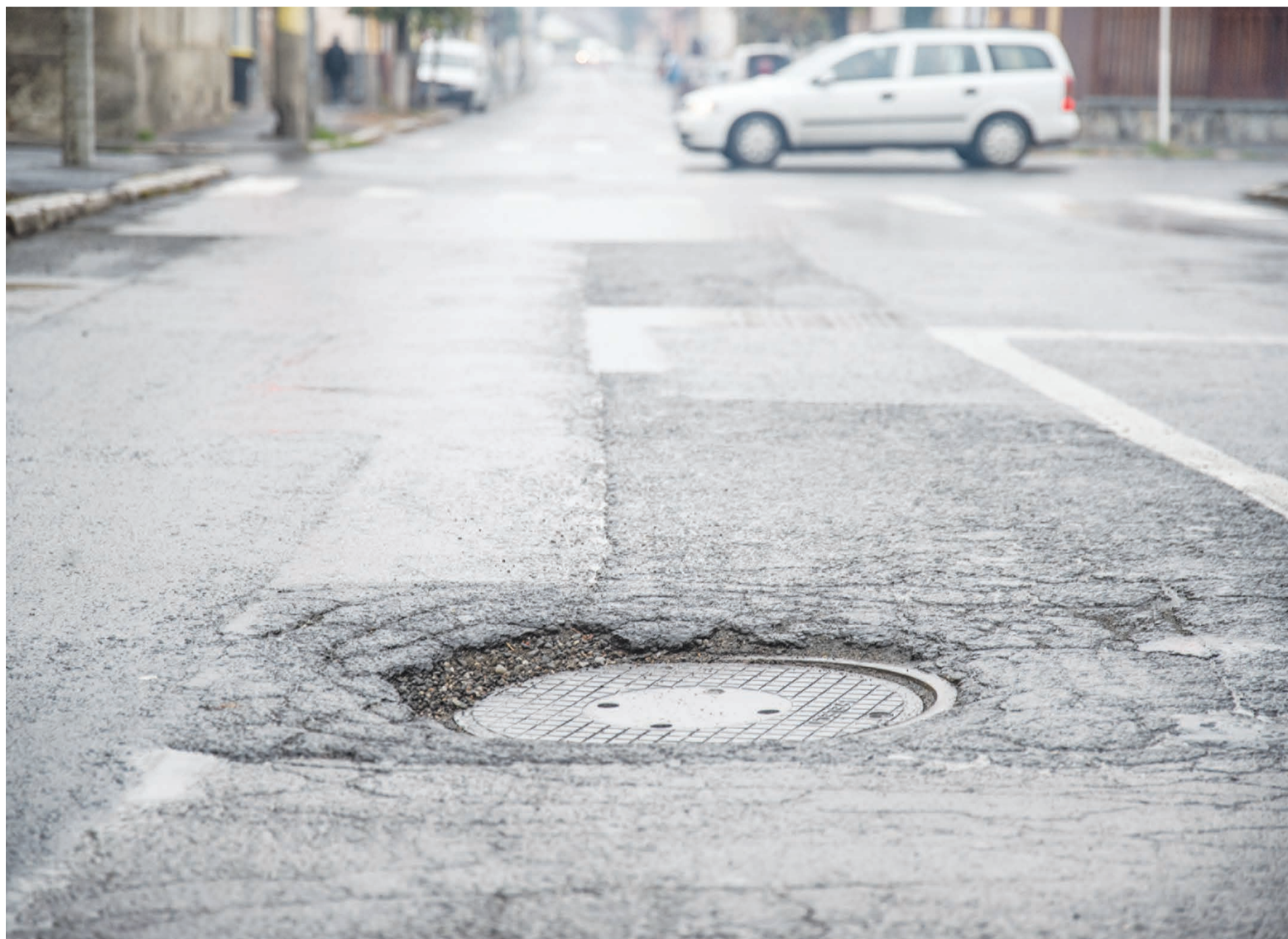
Akárcsak a legtöbb székelyföldi városban, Székelyudvarhelyen is gondot jelentenek a megsüllyedt aknafedők
